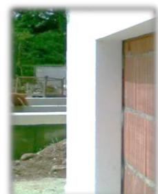
(Legge 9 gennaio 1991, n. 10), con finitura esterna mediante l'applicazione di una prima mano di malta con successiva rete di armatura e una seconda mano di rasatura a fissaggio della rete, successivamente viene applicato uno strato di preparazione del fondo per l'applicazione finale dell'intonaco di finitura; colore a scelta della D.L. Spessore variabile tra i 7 ed i 13 cm.
