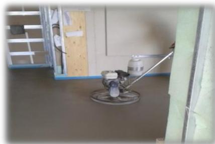
Massetto: in sabbia e cemento con fibre pronto per la posa dei pavimenti interni ed esterni.
